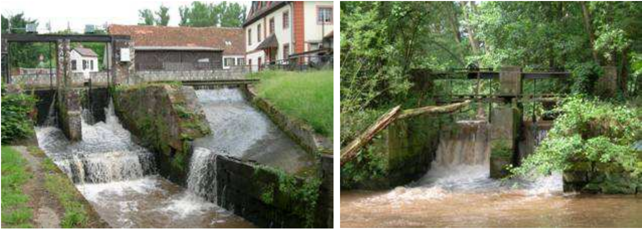
Illustration 3 : Les ouvrages infranchissables de la Lauter (photo de gauche : la Bienwaldmühle, photo de droite : détail de la féculerie de Scheibenhard) (source : S.Kaupe, 2008)
