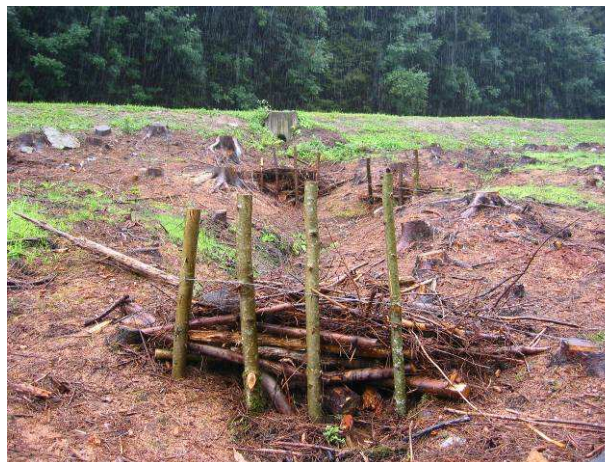
Mise en place de seuils rustiques visant à boucher les drains
