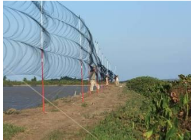
Photo 16. Montage des filets (@Antoine Baglan)
