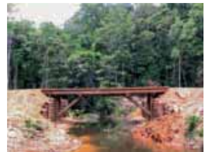
Pont en bois de 16 m de portée sur la crique Portal
