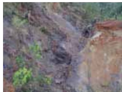
Effondrement d'une route forestière construite en zone d'argiles tachetées et de saprolite
