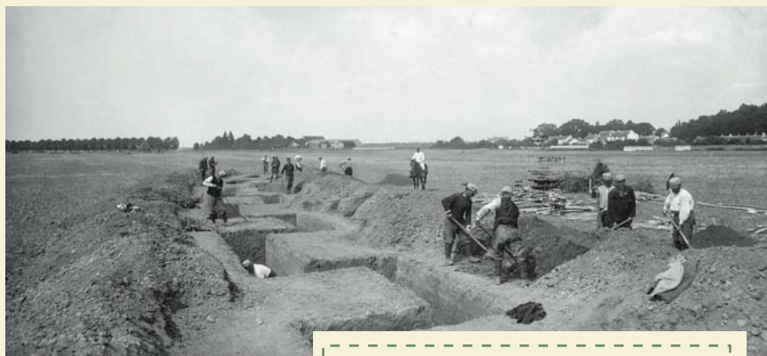
Territoriaux creusant des tranchées
