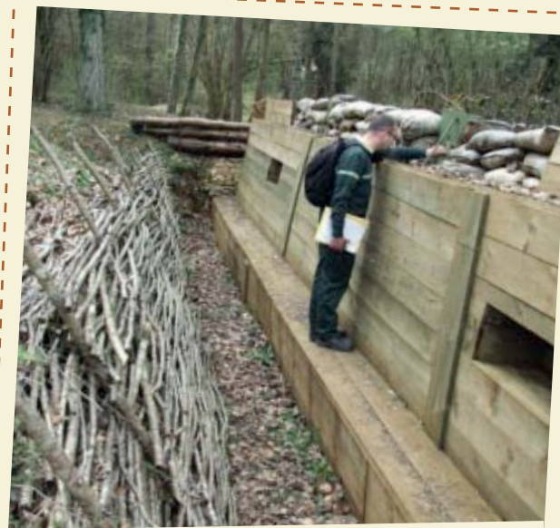
Reconstruction d'une tranchée en forêt
