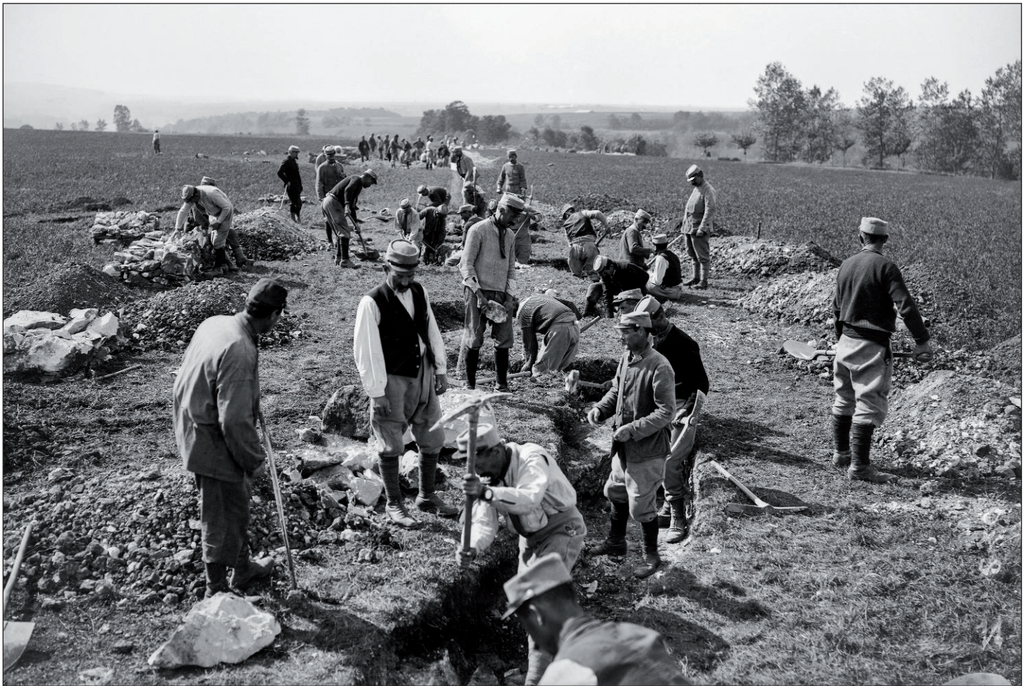
En septembre 1915, à Montefontaine dans l'Aisne des travaux de fortifications (tranchées et abris) sont entrepris par les régiments d'infanterie territoriale rattachés à la 101e DI. © ECPAD, Vernol.
