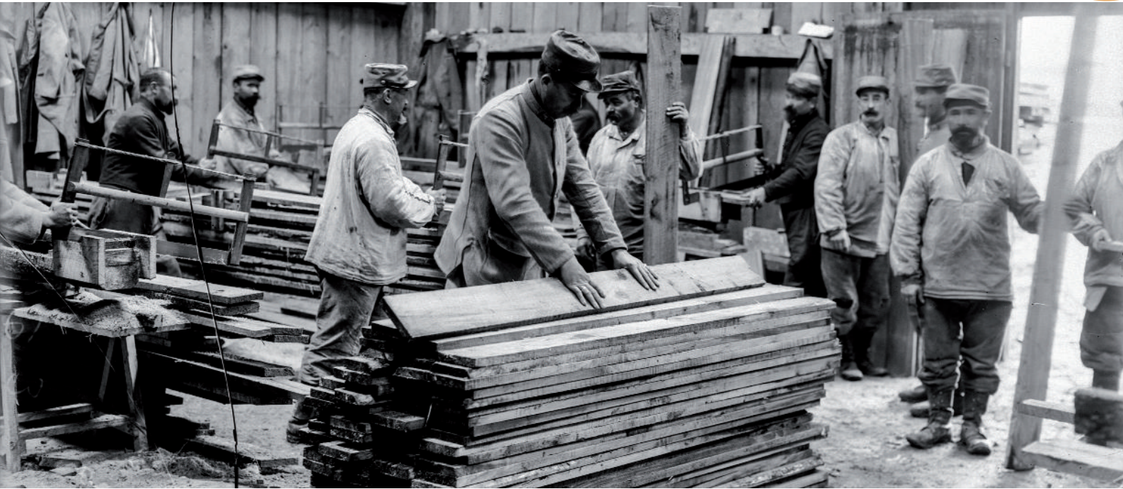
Dans un atelier, à la Fère-Champenoise, des soldats en tenue de travail préparent des planches de coffrage pour les tranchées. © ECPAD, M. Boulay.
