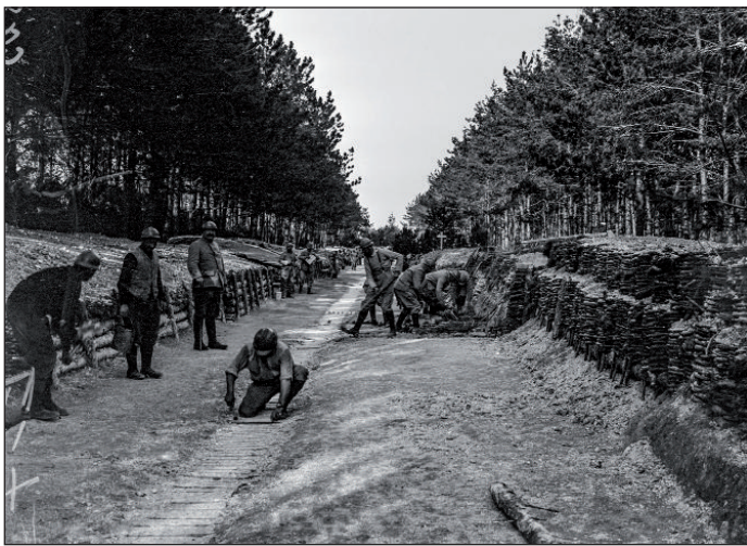
Fabrication de clais pour le renforcement des tranchées, bois d'Hauzy, Marne, juillet 1915. @ BDIC.
