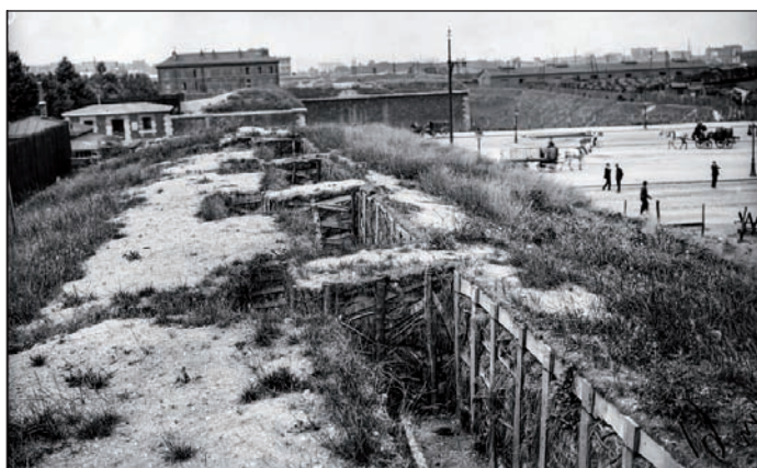
Tranchée renforcée par un étayage de bois, porte de la Chapelle. © ECPAD, A. Moreau.
