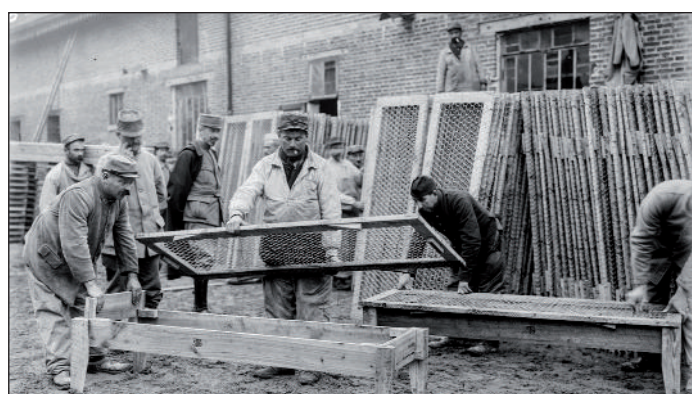
Fabrication de lits de tranchée, Fère-Champenoise, Marne, décembre 1915. © ECPAD, P. Machard.
