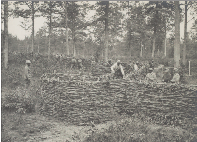
Fabrication de claies pour le renforcement des tranchées, bois d'Hauzy, Marne, juillet 1915. @ BDIC.
