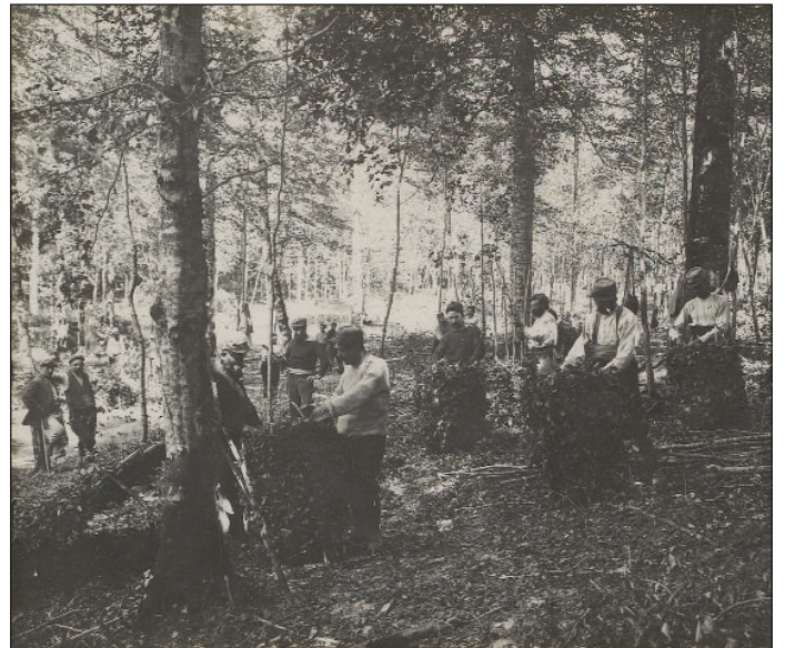
Fabrication de gabions, Villers-en-Argonne, Marne, juillet 1915. @ BDIC.
