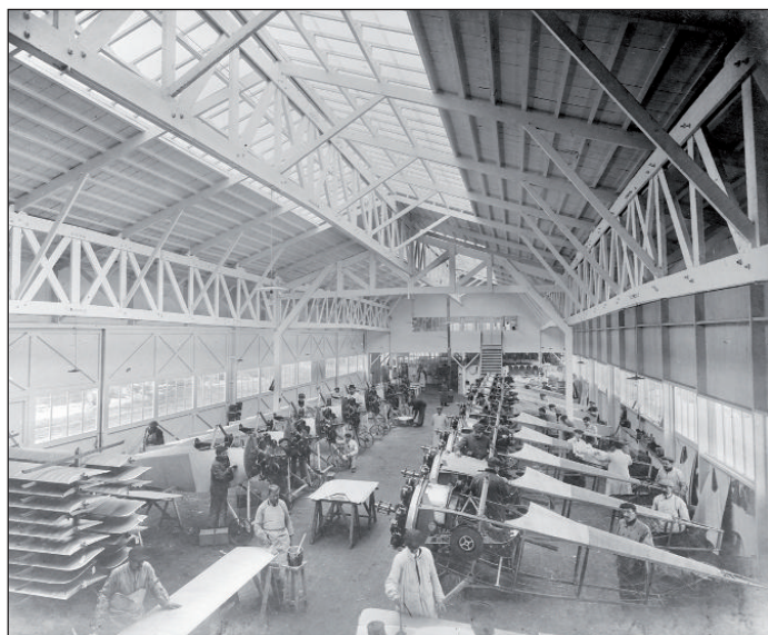
Atelier de montage des fuselages " Nieuport 16 ". Les dos de fuselage sont en bois moulé au milieu et en contreplaqué à l'arrière. A gauche stock d'ailes en bois. © SHD.
