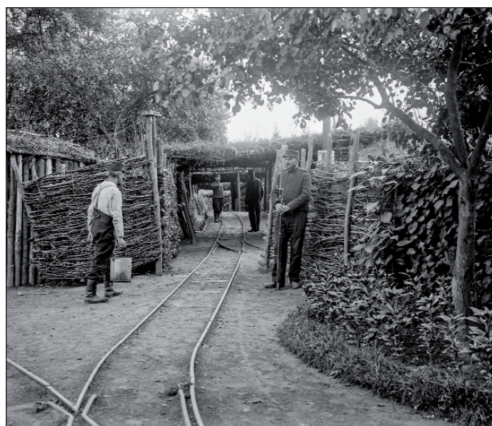
L'entrée de la batterie d'artillerie n°113 à Montigny-Lès-Cormeilles, Val d'Oise. Au sol, un aiguillage de voies ferroviaires étroites, dites voies de 60. Août 1915. © ECPAD, Tétart.
