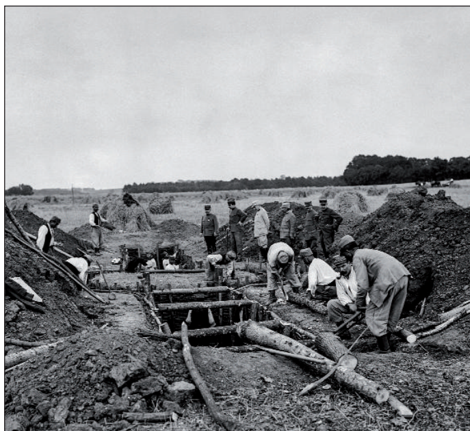
Territoriaux construisant des tranchées à Vemars dans le Nord du Val d'Oise. © ECPAD, A.Moreau.
