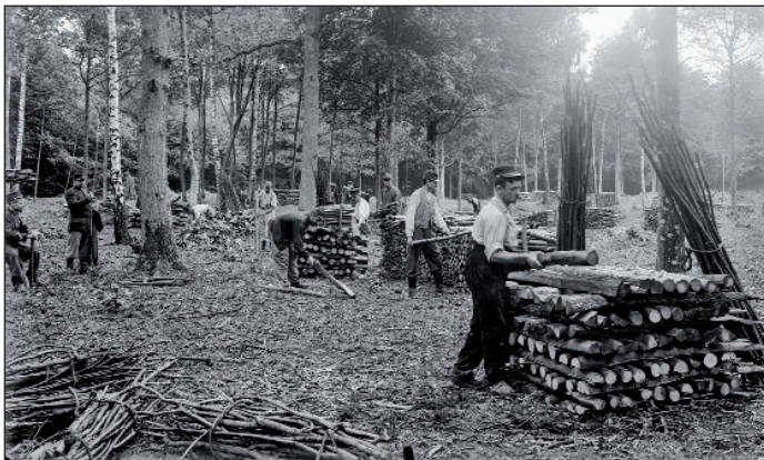
Confection de pieux pour les tranchées en forêt de l'Isle-Adam, Val d'Oise, août 1915. © ECPAD, Tétart.
