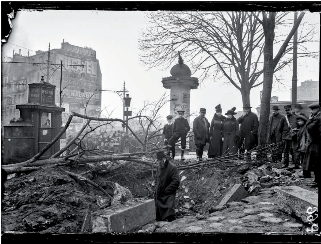
Dégâts causés dans Paris par le raid d'un zeppelin le 29 janvier 1916. Quartier de Menilmontant. © ECPAD, G. Boussugues.
