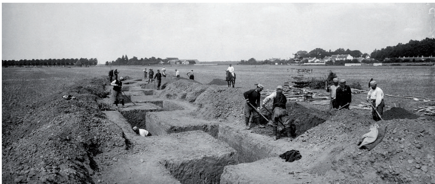
Construction d'une tranchée à Tigery (Essonne) en 1915. © ECPAD, E. Brissy.
